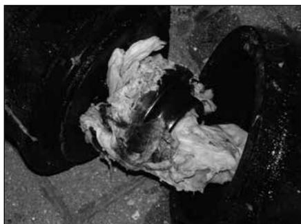
Ein «verzopfter Strang» aus Feuchttüchern hat die Pumpe einer Kläranlage lahm gelegt. Mehrere Stunden Manneskraft sind nötig, um die Pumpe davon zu befreien.
