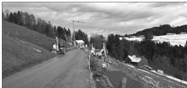
Bau einer Stützmauer zur Sanierung der Strassenschäden nach Starkregen im September 2017.
