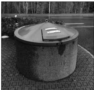
Das Bild zeigt einen fertig eingebauten Unterflurcontainer aus der Gemeinde Heiden.
