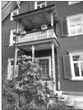
Rechts, Detail Balkon Holderenstr. 26: Wohnbereich mit Südbalkon 1. Stock.
