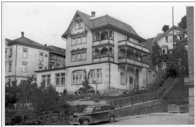
Oberstrasse 12, Südverandas um 2019 entfernt
